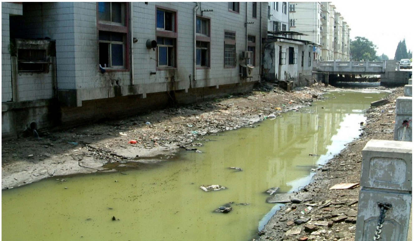
Figura 4a. Descarga directa de aguas residuales sobre un canal de desagüe pluvial en el barrio de Huaxin en Shanghái, China
