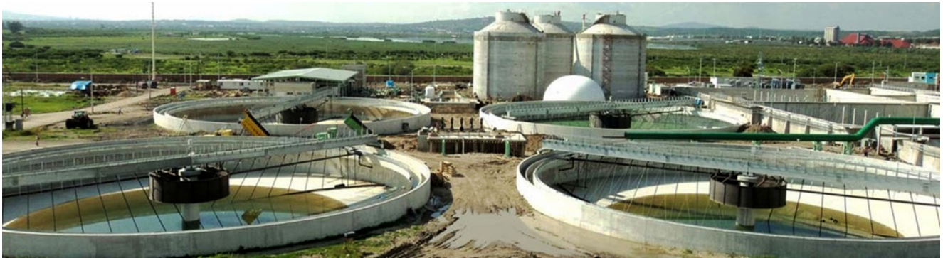
Figura 1. Planta de tratamiento de aguas residuales El Ahogado, con capacidad de tratamiento de 2 250 litros por segundo, localizada en Guadalajara, Jalisco
