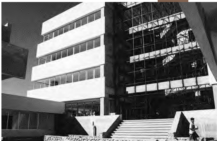
Instalaciones de la unidad Tapachula.
