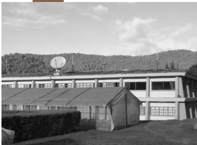
Instalaciones de la unidad San Cristóbal.
