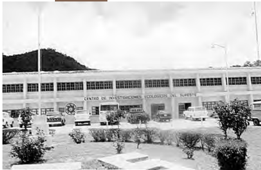
Vista del CIES, lo que actualmente es el edificio D de la unidad San Cristóbal.
