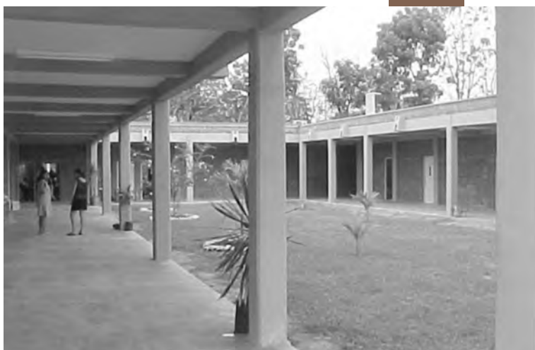
Instalaciones de la unidad Villahermosa
