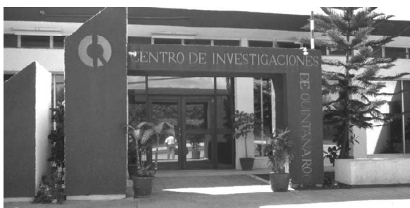
Acceso a las instalaciones del CIQRO en Chetumal.
